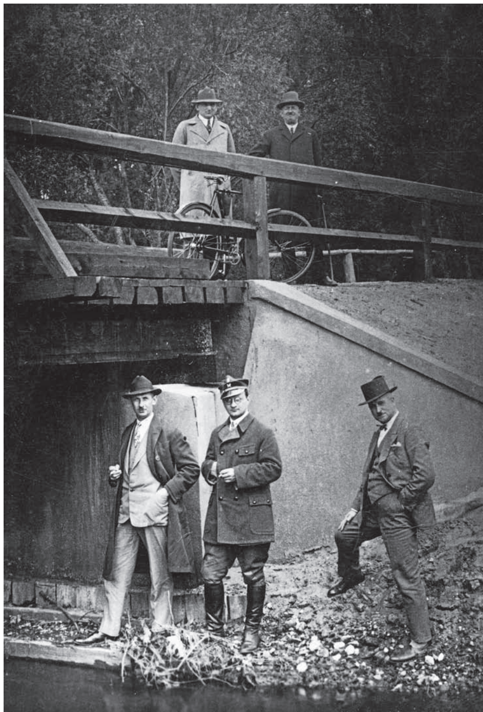
Inspektorzy z Dyrekcji Lasów Państwowych w Bydgoszczy dokonują odbioru mostu na rzece Zielonej w Nadleśnictwie Osiek, koniec lat 20. XX w. Fot. archiwum
