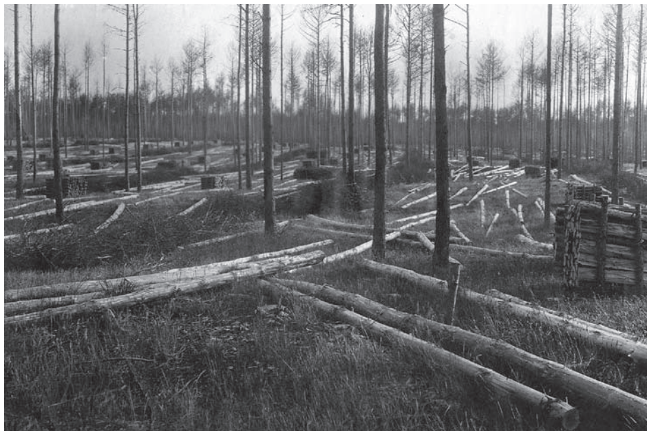
Wyrąb drzewostanu sosnowego zniszczonego żerem barczatki na terenie Nadleśnictwa Osiek w Puszczy Bydgoskiej w latach 30. XX wieku. Fot. archiwum
