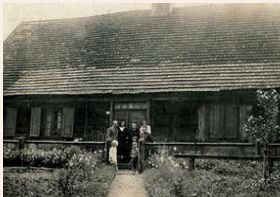
Stary drewniany budynek leśniczówki Zwierzyniec ok. 1937 r.
