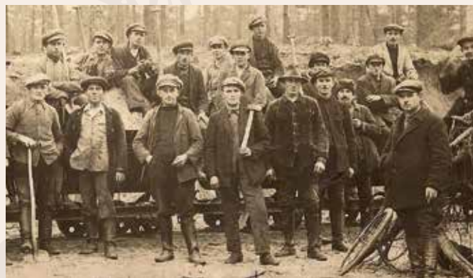
Ignacy Rząska z młotem na ramieniu. Grudzień 1928. Budowa linii kolejowej - odcinka magistrali węglowej od stacji Lipowa do stacji Łąg.
