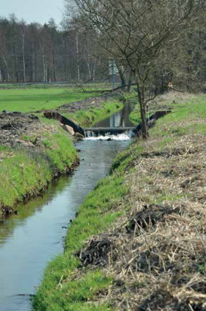
Próg piętrzący na cieku wodnym
