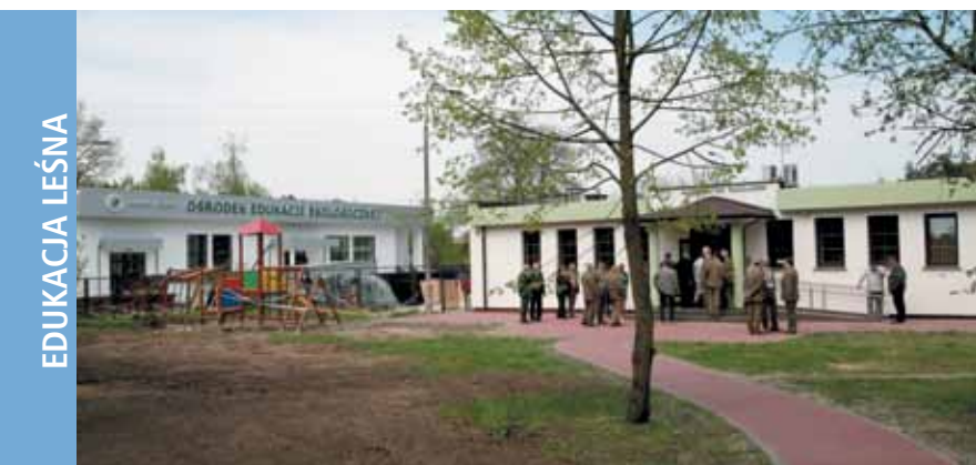
Ośrodek edukacji (po lewej, w budowie) oraz budynek dydaktyczno-konferencyjny
