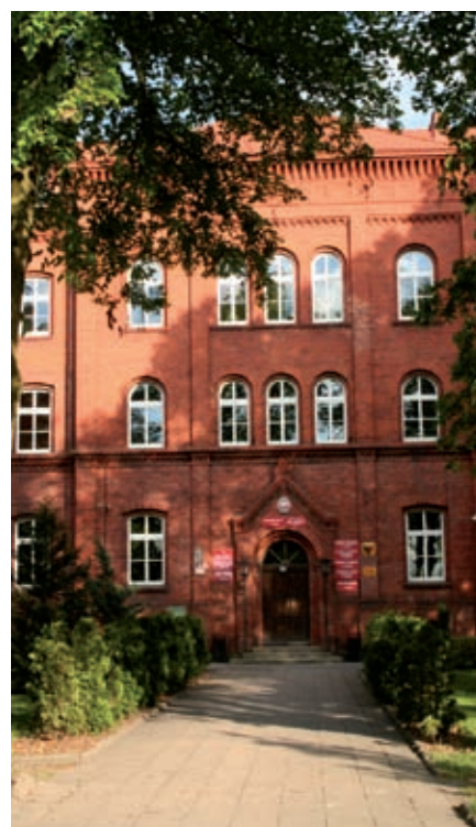
Budynek ZSL w Tucholi. Fot. arch. ZSL
