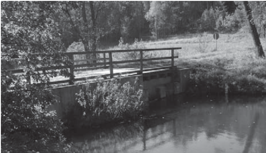
Przepust na rzece po remoncie w 2007 r. Fot. Nadleśnictwo Przymuszewo
