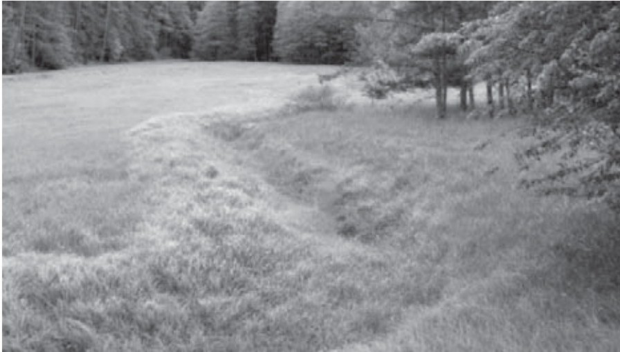
Istniejący kanał nawadniający. Fot. Nadleśnictwo Przymuszewo
