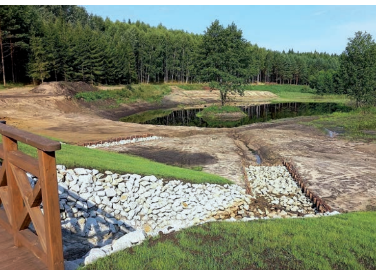
Obiekt małej retencji na końcowym etapie budowy
