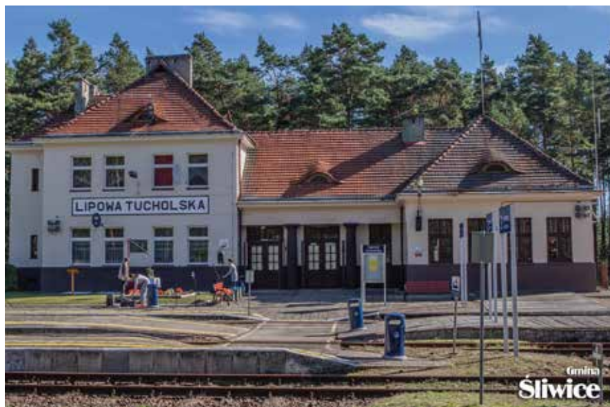
Na ścianie budynku stacji w Lipowej umieszczono tablicę upamiętniającą Danutę Siedzikówną
