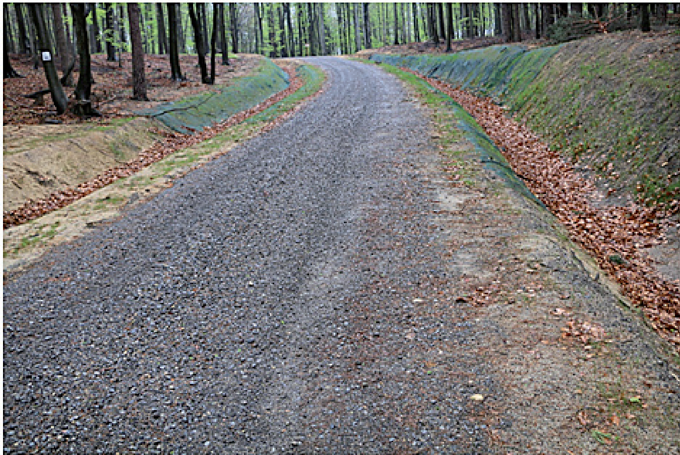
Rysunek 1.2. Widok na drogę leśną zbudowaną z kruszywa naturalnego (fot. M. Zajączkowski)
