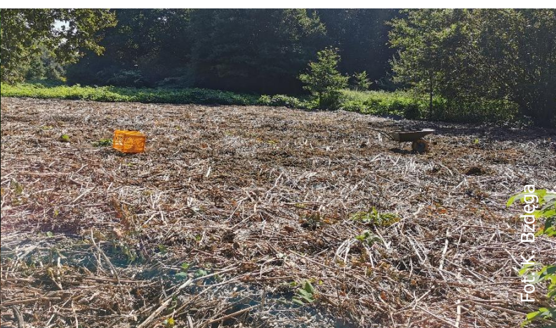
Rozsypywanie zrębki na wysuszone, rozdrobnione pędy rdestowca – warstwa ochronna
